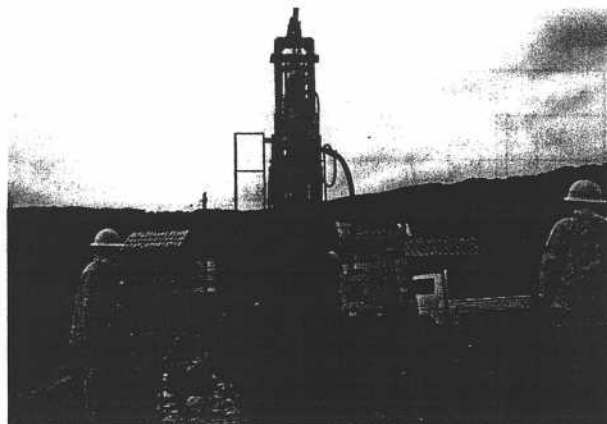
写真-1 揚水井・還元井掘削状況(揚水井掘削中(エアハンマー法))
