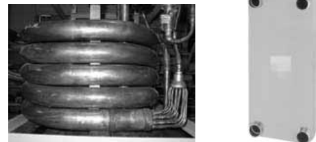
写真-1 熱交換器(左より多重管式, プレート式)
