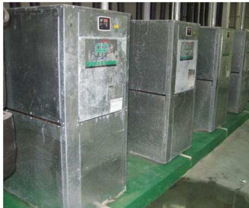
写真2 ヒートポンプの設置状況
