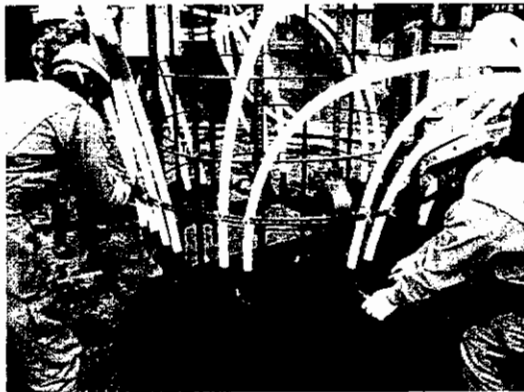
図-5 Uチューブ設置状況
